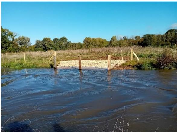
*Photo d'un abreuvoir stabilisé*
