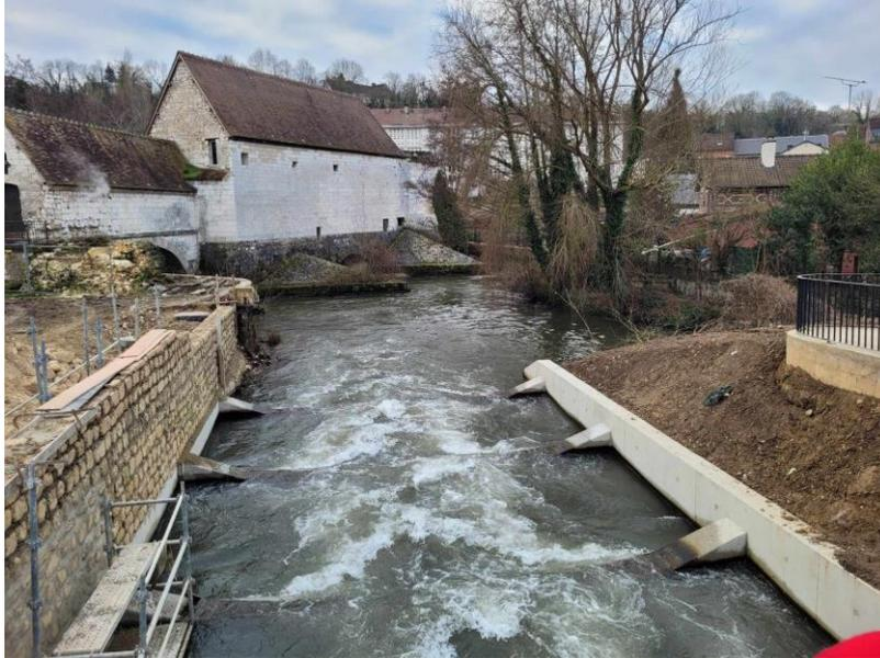
Les travaux en 2024 ont consisté à terminer le mur en pierre de taille, réaliser les joints à la chaux et stabiliser le talus en terre en rive droite. Ces actions étaient obligatoires, afin de mieux inclure cet ouvrage dans le visuel de la tour Boileau (prescriptions de l'Architecte des Bâtiments de France).
