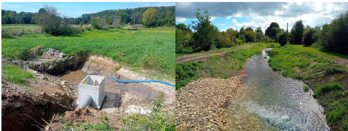
*Photos de la mise en place du moine (sortie de l'étang) et du bras de cours d'eau ressortant de l'étang après sa remise en eau.*
