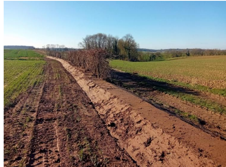
Mise en place de talus
