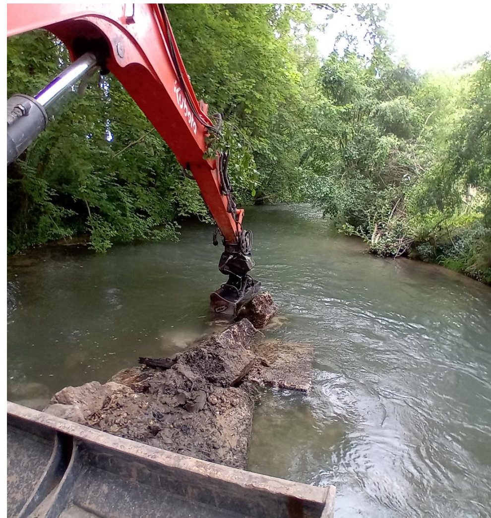
AMENAGEMENT DE L'ENTRÉE HYDRAULIQUE ENROCHEMENT
