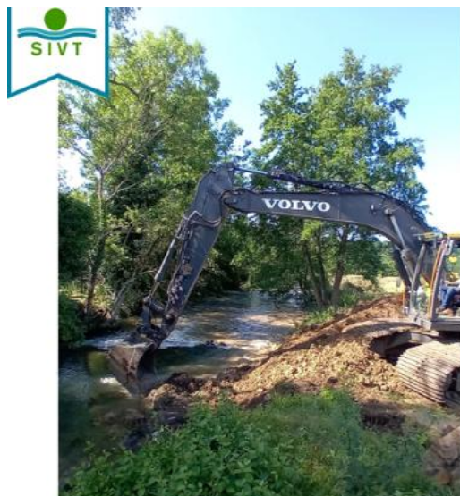
Travaux d'aménagement du seuil : ► SUPPRESSION PARTIELLE DU RADIER
