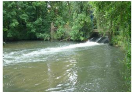
OUVRAGE DE DÉCHARGE N°2
