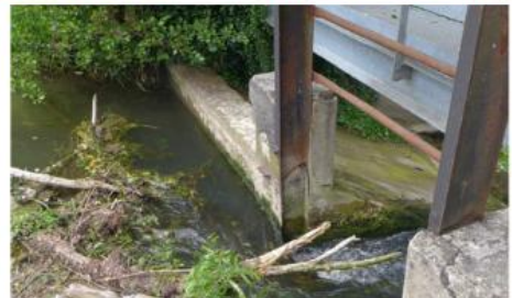
OUVRAGE DE DÉCHARGE N°1
