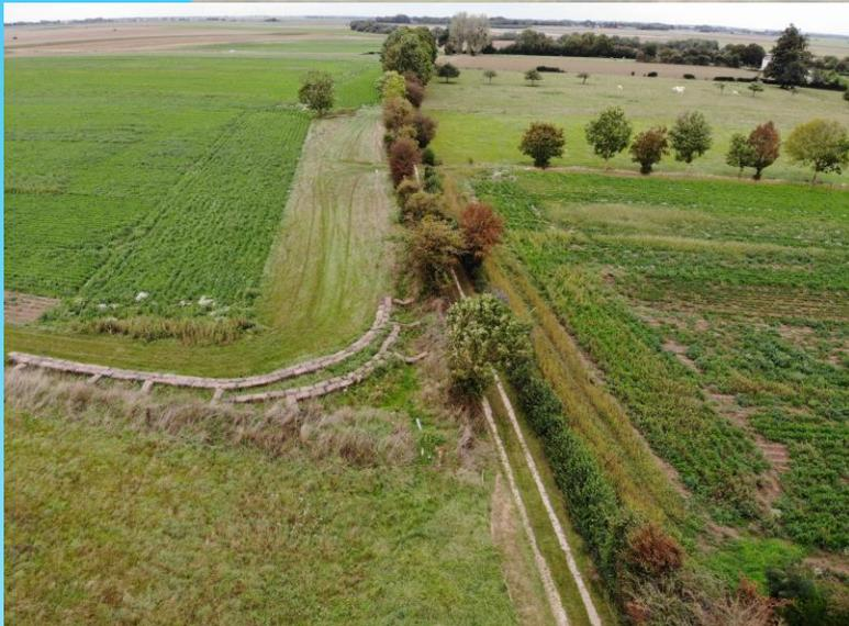
Pose de carrés de pailles et d'un tuyau dans le talus existant
