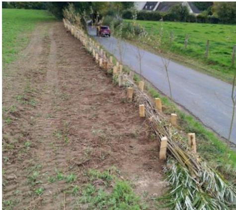
Ce type d'aménagement placé dans l'axe d'écoulement des eaux permet de retenir les terres tout en étant perméable.
