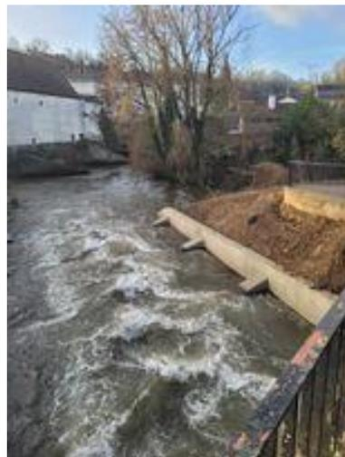
Les travaux se termineront début 2024 par la reprise des parties aériennes avec en rive gauche la reconstruction d'un mur en pierre de taille et en rive droite la remise en talus végétalisé de la zone.
