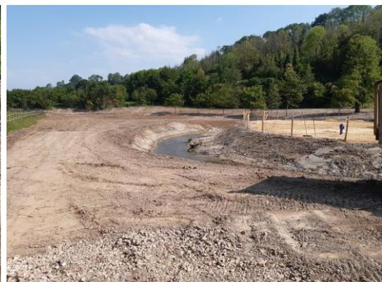
Creusement du nouveau lit du Thérain et dépôt des terres le long du bief du moulin pour être réutilisé.
