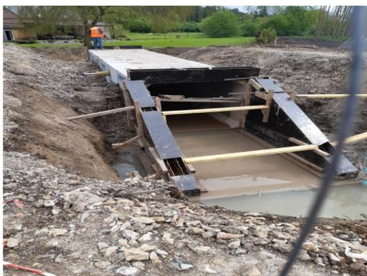
Installation d'un pont cadre sur micro pieux sous la voirie pour accéder au moulin.
