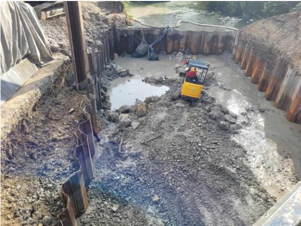
Dans le même temps un lit de blocs et cailloux a été déposé au fond du lit permettant à la future passe à poissons de reposer sur un socle stable.
