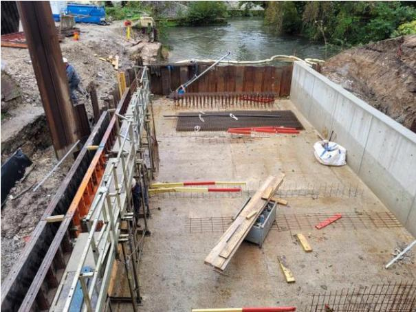
Une fois les murs et le fond de la passe coulés, les six cloisons séparant les bassins ont été créées. La forme des hauts de cloisons permet de créer de petite chute entre chaque bassin permettant aux poissons de franchir l'ouvrage.
