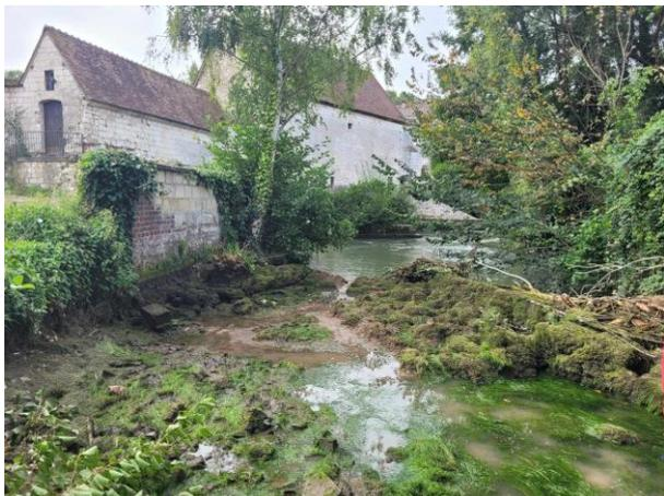
Les travaux devant se faire à sec, il a été nécessaire de dévier les eaux du Thérain. Pour se faire un lit temporaire a été creusé en rive droite, en accord avec le propriétaire privé (M. Kotarski) et raccorder derrière la chute.
